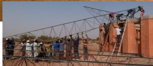
Aufsetzen der Dachkonstruktion
